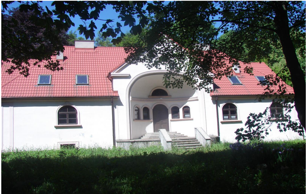
Fot. 11. Dworek w Dębowicach. Podlaski 2015.
